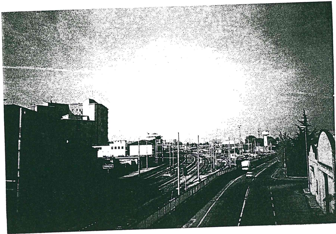
SNODO FERROVIARIO DELLA STAZIONE DI MODENA
